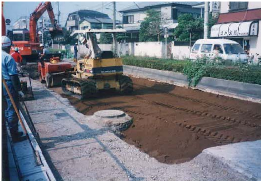
改良土敷均し状況
