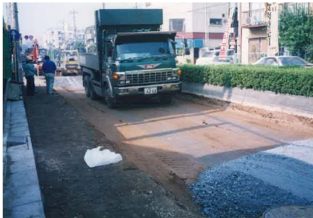
改良土転圧完了
